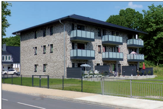
Ein echtes Vorzeigeobjekt: Das Mehrfamilienhaus in der Hindenburgallee, das Dose+Sohn schlüsselfertig übergeben hat.
